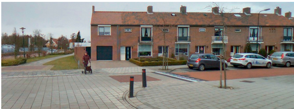
Figuur 5.4 Verkeersplateau houdt water op straat tegen.
